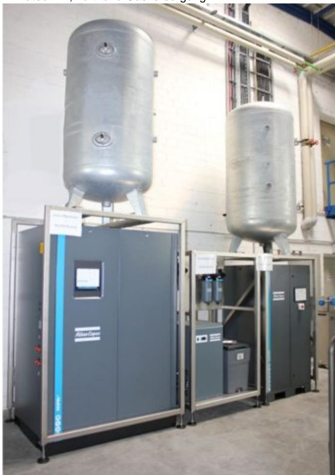
Der zweistufige Stickstoffgenerator filtert N<sub>2</sub> mit einer Reinheit von bis zu 99,9 % aus der Umgebungsluft (Bild: m + f).
