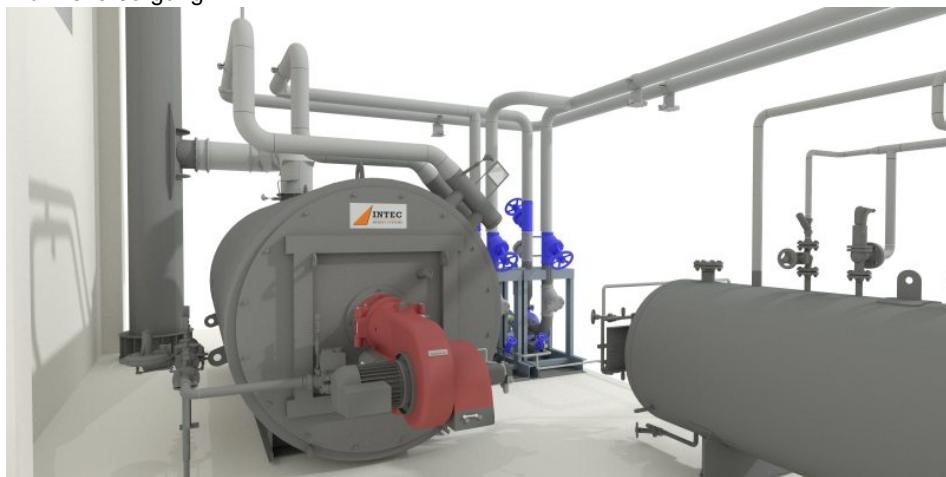
Die ProzesswärmeverSORGungsanlage für eine neue Kartoffelchips-Linie umfasst u. a. einen maßgeschneiderten Thermalölerhitzer (Bild: Intec Engineering).
