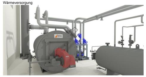
Die Prozesswärmeversorgungsanlage für eine neue Kartoffelchips-Linie umfasst u. a. einen maßgeschneiderten Thermalölerhitzer (Bild: Intec Engineering).
