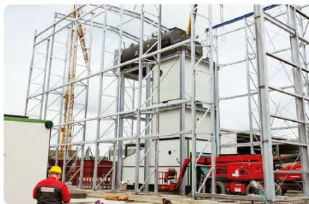
Die Anlagen werden in der vertikalen Bauweise errichtet.
