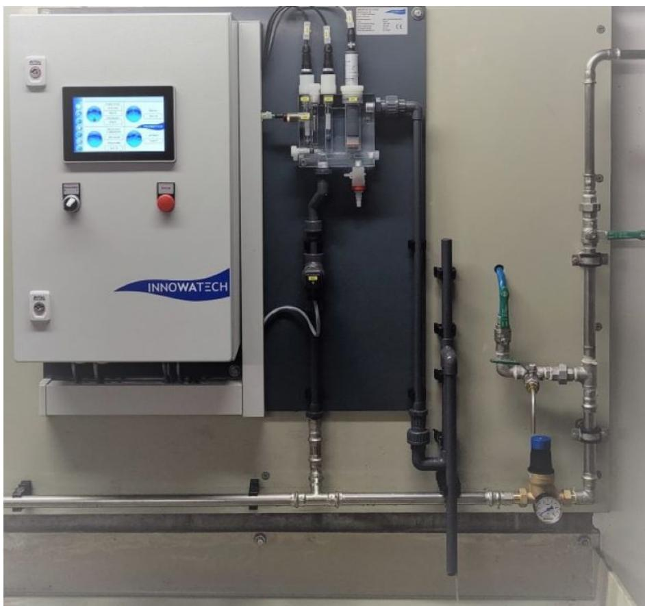
Das Multi-Mess-Center misst permanent den Wirkstoffgehalt im Trink- und Prozesswasser, steuert die Wirkstoffdosierung entsprechend vorgegebener Sollwerte und dokumentiert alle Parameter. Beim Einsatz in Kühlwassersystemen entfallen dadurch die 14-tägigen mikrobiologischen Analysen nach 42. BlmSchV (Bild: Innowatech).
