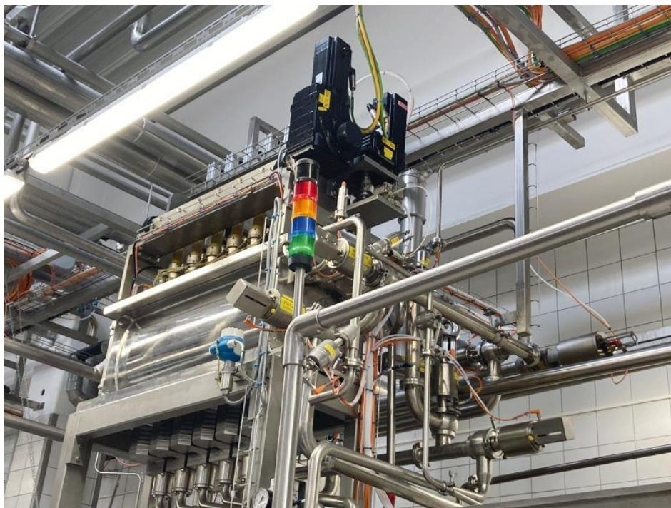
In der Abfüllmaschine kamen »CMP«-Servomotoren (im Bild) sowie Planeten- und Standardgetriebe mit Beschichtung im Hygienic Design zum Einsatz (Bild: SEW).
