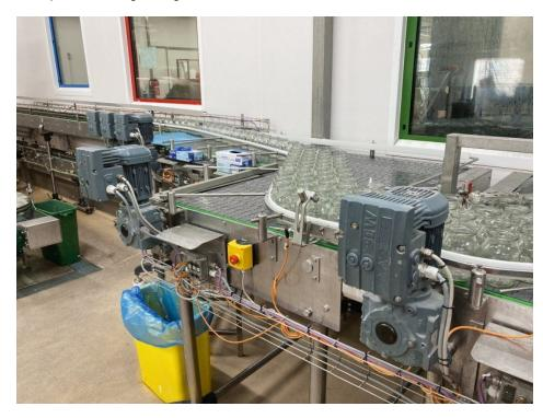
Die dezentrale Antriebstechnik arbeitet zuverlässig sowie energieeffizient und ist wartungsarm (Bild: SEW).
