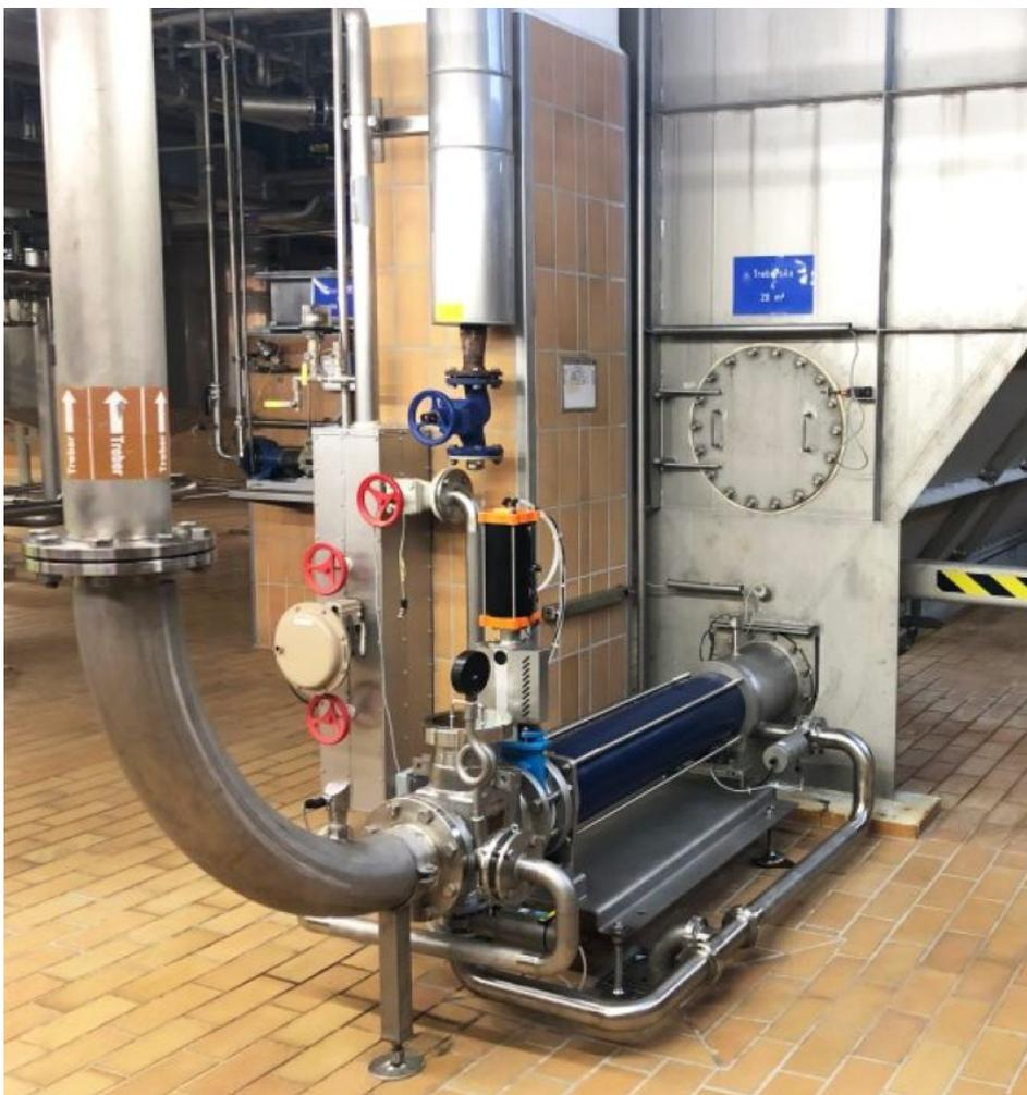
Das neue Fördersystem (oben) spart bis zu 95 Prozent Energie gegenüber der bisherigen konventionellen pneumatischen Nasstreber-Förderung (unten) ein (Bild: Seepex).
