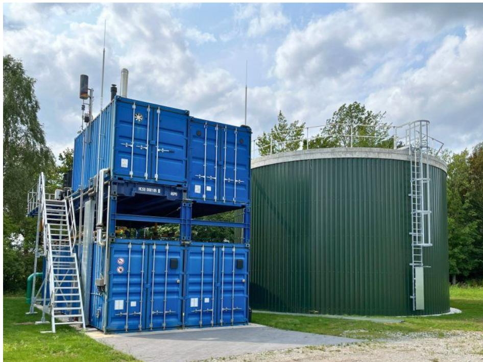
Diese Abwasserbehandlungsanlage bestehend aus einem 20-Fuß-, drei 40-Fuß-Containern und einer Plattform mit Gasaufbereitung arbeitet zuverlässig bei einem Feinkostunternehmen in Nordrhein-Westfalen (Bild: FlexBio).
