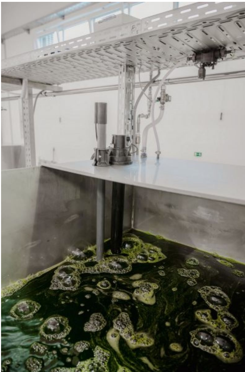
Auslaufbehälter mit Eintaucharmaturen für pH-, Leitfähigkeits- und Trübungsmessung (Bild: Endress+Hauser).
