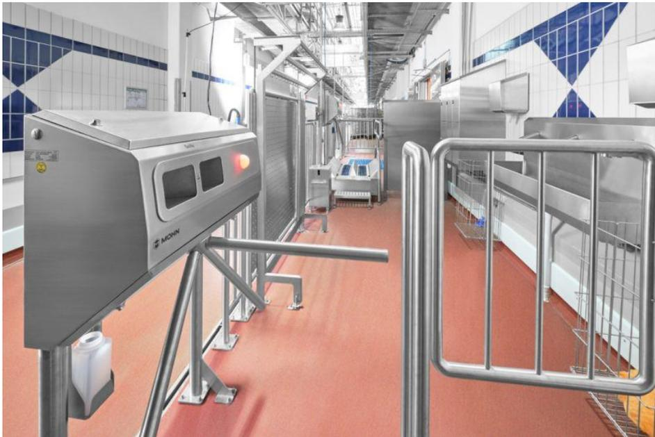
Hauptgang der Personal-Hygienschleuse, links im Vordergrund der Seifenautomat mit überlastungssicherer Sensortechnik, rechts die sensorgesteuerte Mehrplatz-Waschrinne und im Hintergrund überlastungssichere Zweihand-Desinfektion sowie Sohlenreinigung und Desinfektion (Bild: Mohn).
