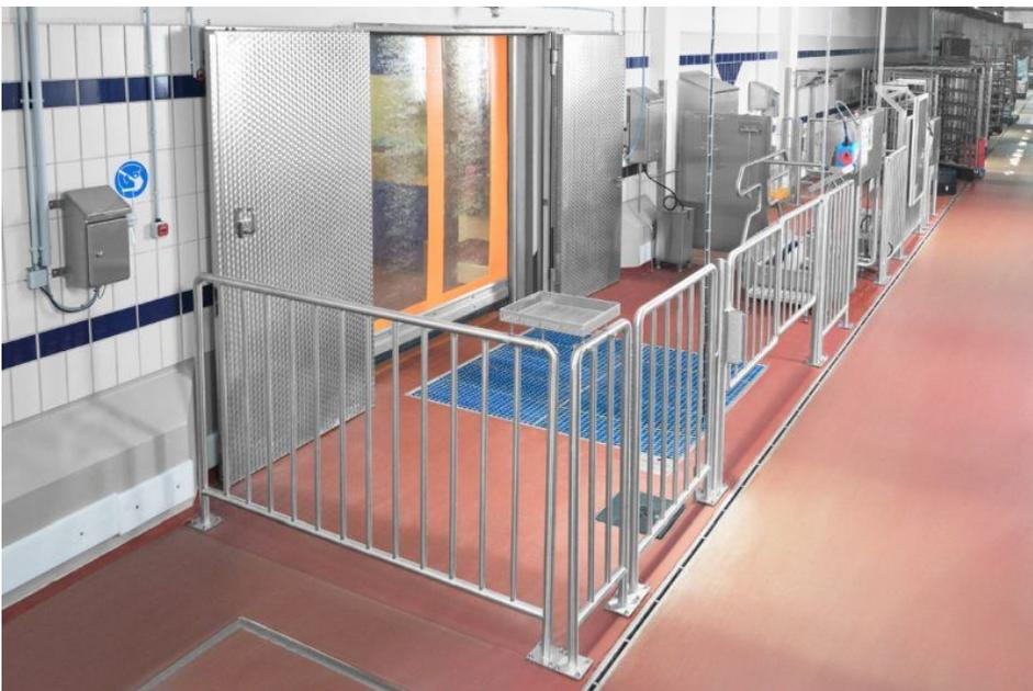
Die Magnettore sind fluchtwegtauglich und koppelbar mit der Brandmeldeanlage (Bild: Mohn).
