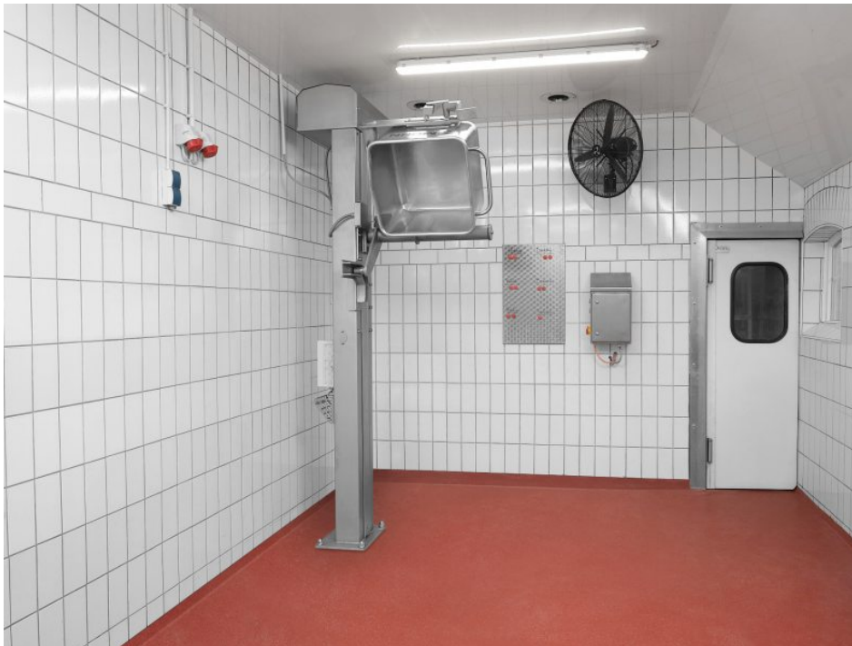
Hebe-Kippvorrichtung in Kippposition (Bild: Mohn).
