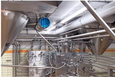
Die UVC-Umluftentkeimer reduzieren zusammen mit Luftentfeuchtungsanlagen die Schimmelbelastung (Bild: Sterilair).
