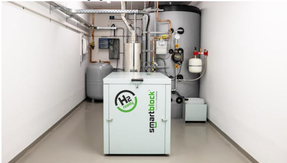
Die BHKW werden z. B. mit Pflanzenöl betrieben, die Beimischung von Wasserstoff ist möglich (Bild: KW Energie).
