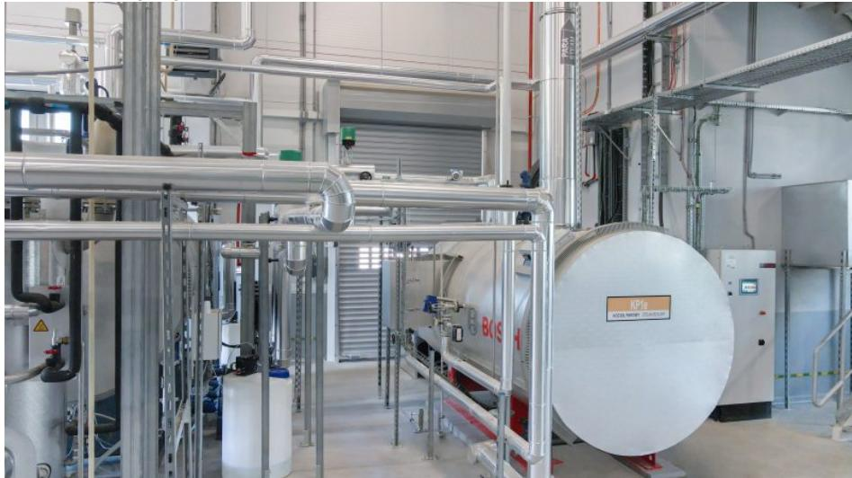
Der Elektrodampfkessel bei PepsiCo erzeugt mit 3,6 MW Grünstrom bis zu 5 t Dampf pro Stunde (Bild: Bosch).
