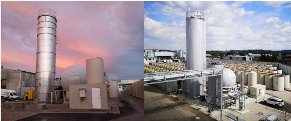
Abwasserbehandlungsanlage für den Fabrikationsstandort Dingolfing von Develey (Bilder: Martin Schaub, Wehrle).
