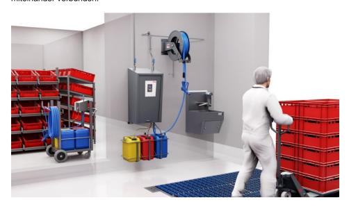
Hauptstation der Niederdruck-Schaumreinigungsanlage und mobiler Fahrwagen (Bild: PHT).
