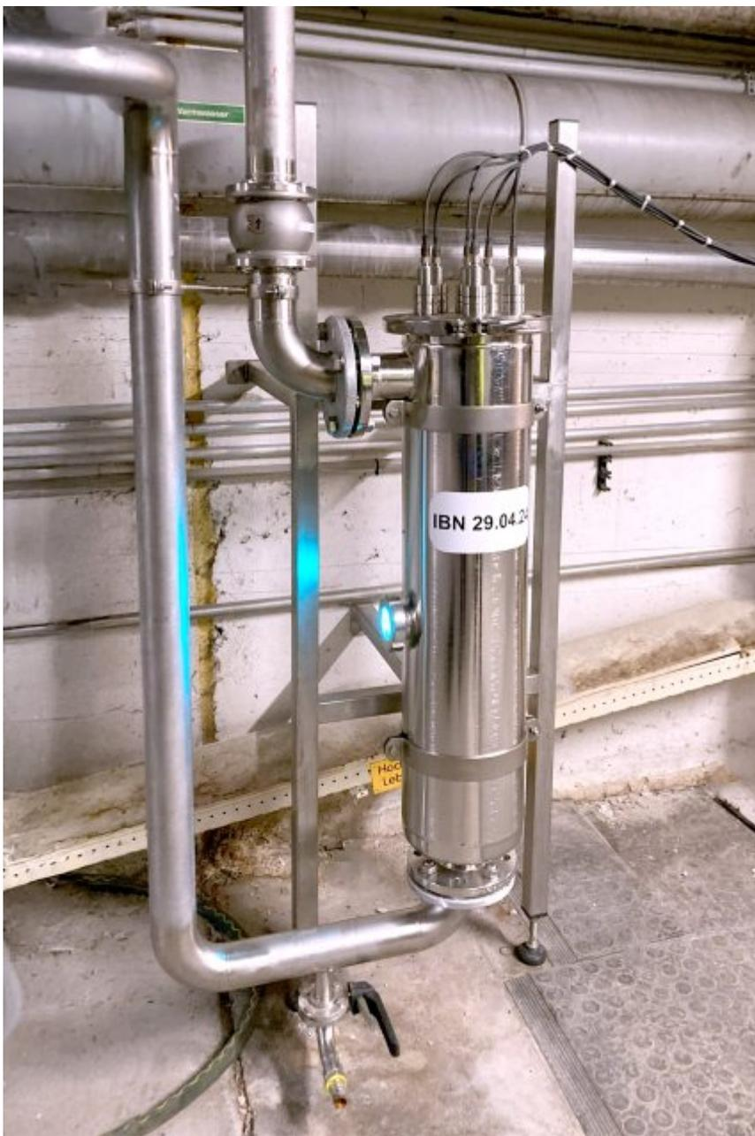
Durchlaufreaktor zur UVC-Entkeimung für die Sicherstellung der Spülwasserqualität (Bild: Sterilair).
