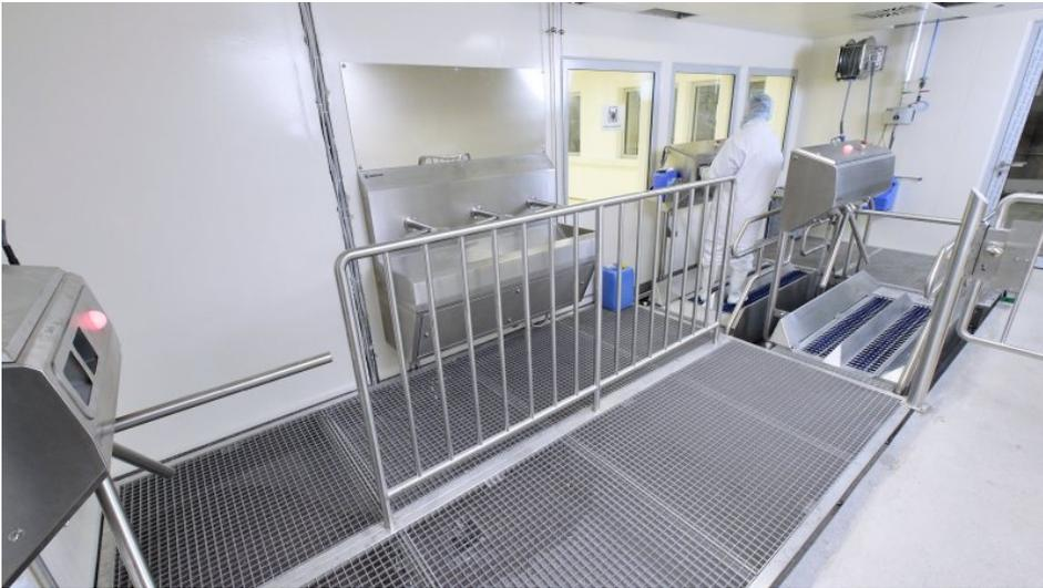
Die bodenebene Personal-Hauptschleuse ist das zentrale Hygienezugangssystem des Backwarenbetriebs (Bild: Mohn).
