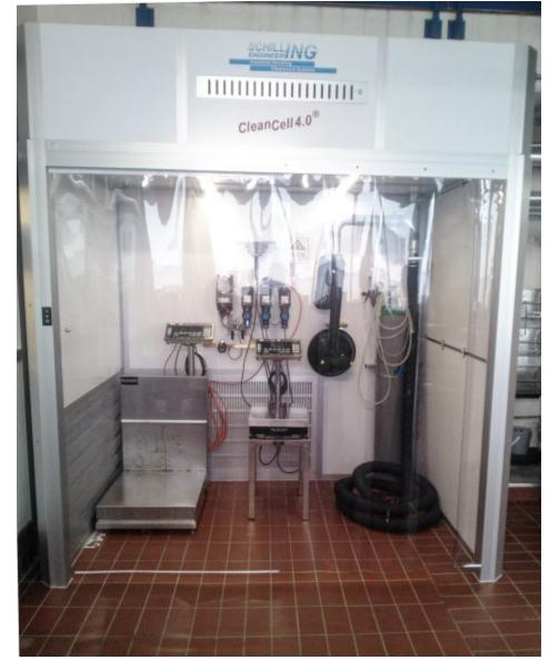
Die kompakte Reinraumanlage verhindert Kontaminationen bei der Pulverabfüllung (Bild: Schilling Engineering).
