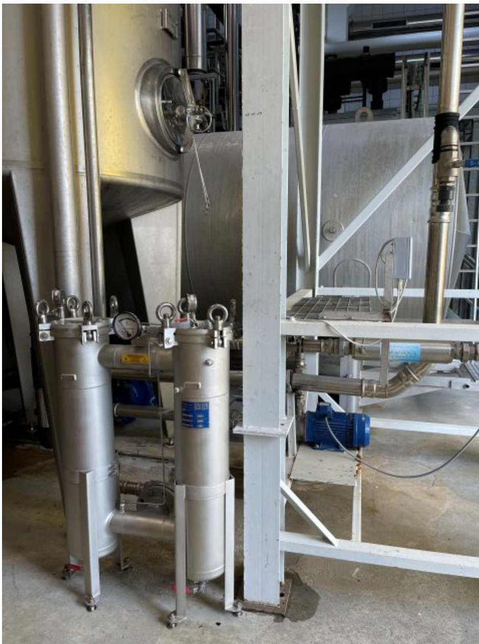
Einbau der chemiefreien Wasserbehandlung in einem Bypass (Bild: Aquaenergy).
