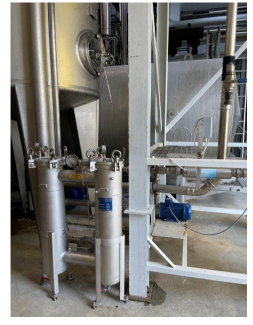
Einbau der chemiefreien Wasserbehandlung in einem Bypass (Bild: Aquaenergy).
