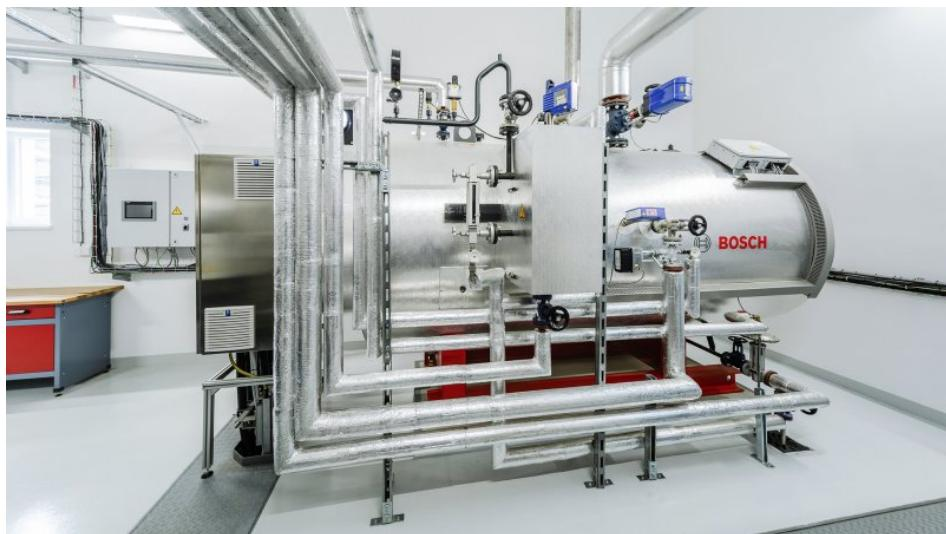
Auf dem Drinktec-Messestand wird auch dieser Elektrodampfkessel ausgestellt
