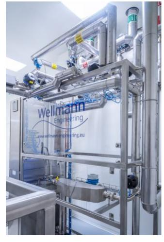
Leicht an viele Anwendungsfälle anpassbar, reinigen vollautomatische CIP-Anlagen Leitungen und Komponenten schnell und effizient (Bild: Wellmann).
