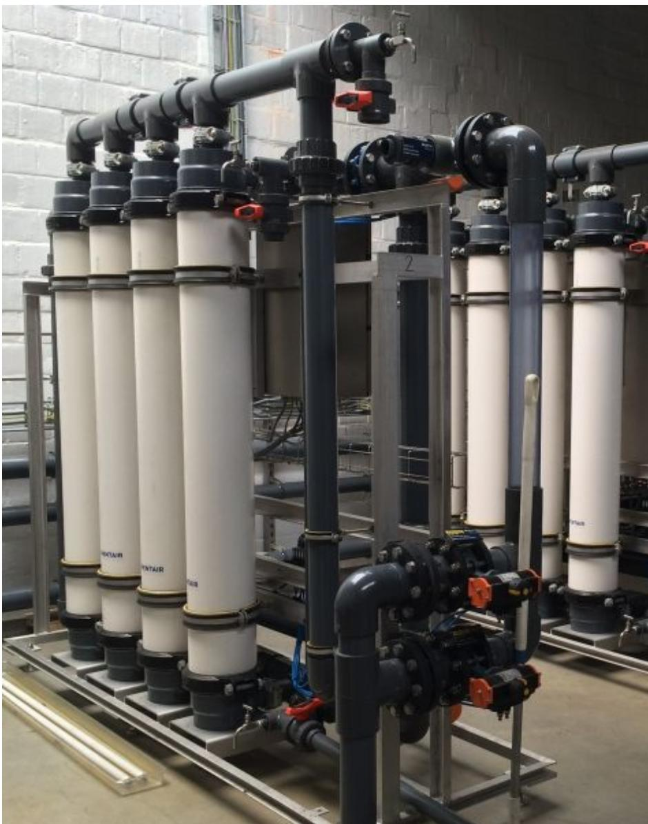
Mit dem »Daireuse«-Verfahren von Veolia werden Brüdenwasserkondensate wieder aufbereitet.
