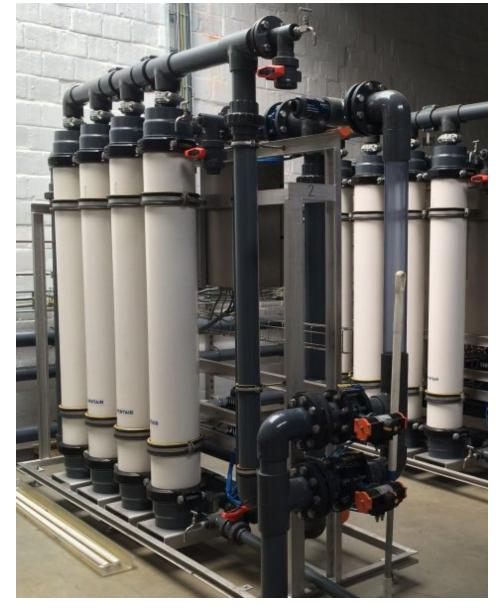
Mit dem »Daireuse«-Verfahren von Veolia werden Brüdenwasserkondensate wieder aufbereitet.
