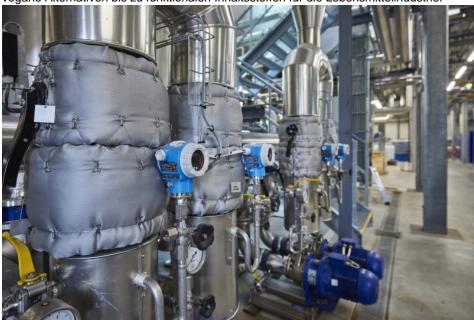
Drucküberwachung im Heißwasser- und Dampfkreislauf (Bild: Endress+Hauser).
