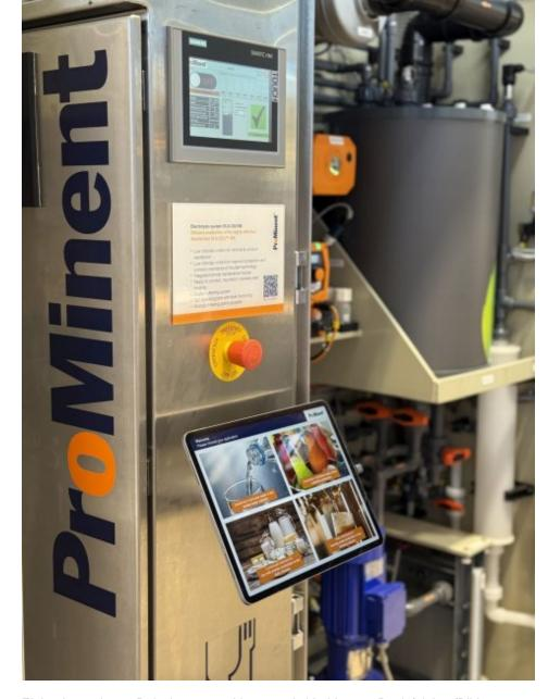
Elektrolyseanlage »Dulcolyse« zur chlorat- und chloridarmen Desinfektion (Bild: ProMinent).
