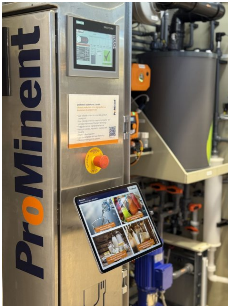
Elektrolyseanlage »Dulcolyse« zur chlorat- und chloridarmen Desinfektion (Bild: ProMinent).
