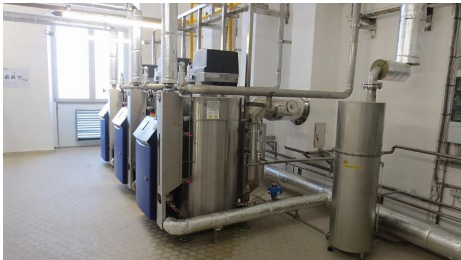
Kompaktes Anlagendesign: Jumag-Dampfanlagen nutzen den vorhandenen Platz bei Walderbräu bestmöglich aus. Bild: Jumag
