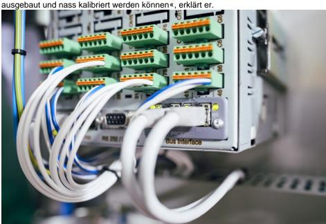
Schaltschränke wurden im Kesselhaus modernisiert und auf Profinet umgerüstet. Bild: Endress+Hauser
