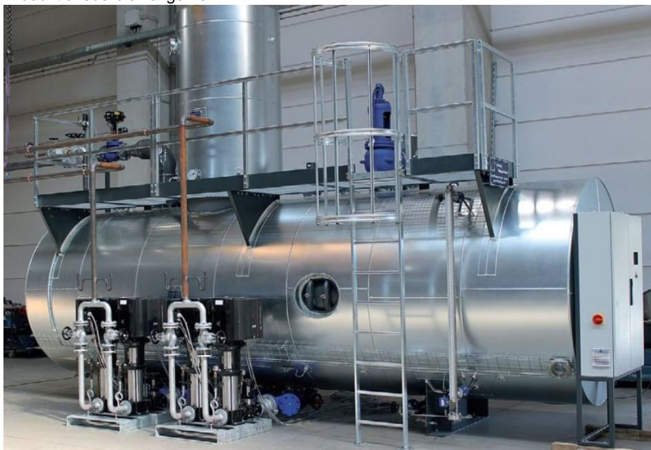
Für die Feldschlößchen Brauerei fertigte Hagelschuer das größte Speisewassergefäß seiner Firmengeschichte. Bild: Hagelschuer
