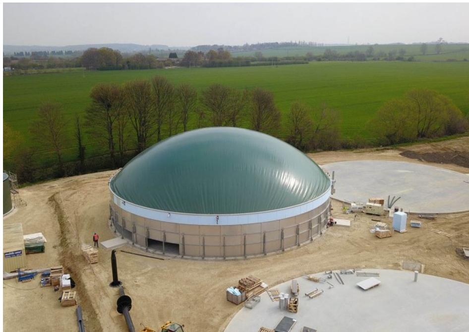
Die Bioreaktoren sollen täglich mit mehr als 250 Tonnen Lebensmittelresten befüllt werden (Bild: Weltec Biopower).
