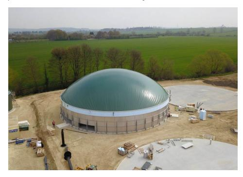
Die Bioreaktoren sollen täglich mit mehr als 250 Tonnen Lebensmittelresten befüllt werden (Bild: Weltec Biopower).
