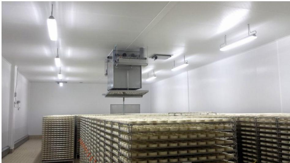
Das kanallose, selbstreinigende Klimasystem sorgt für bestmögliche Reifebedingungen
