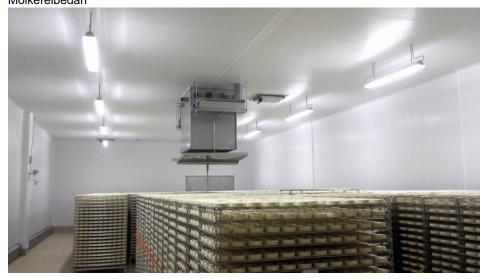
Das kanallose, selbstreinigende Klimasystem sorgt für bestmögliche Reifebedingungen (Bild: Stadler Luftklima).
