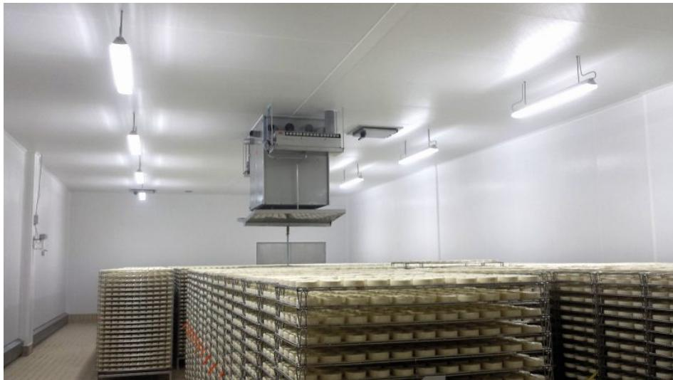
Das kanallose, selbstreinigende Klimasystem sorgt für bestmögliche Reifebedingungen
