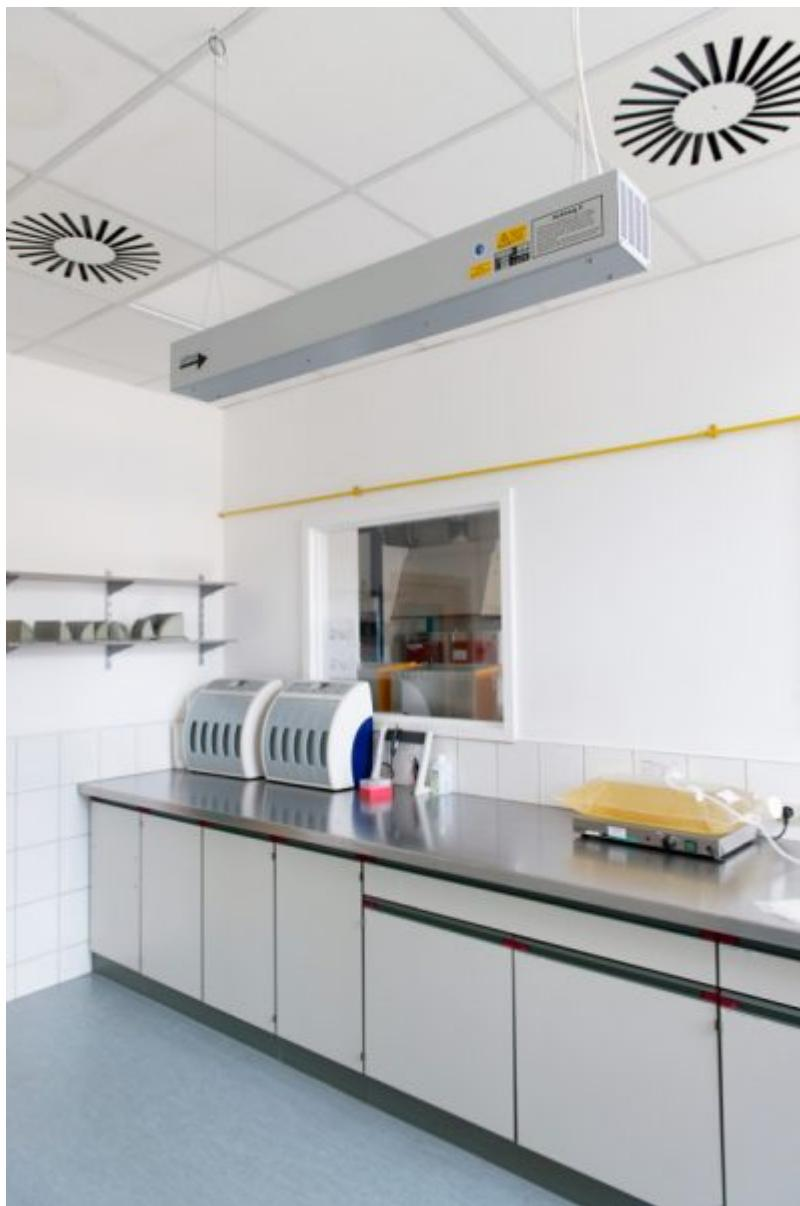
UV-C-Strahlung wird zur Abtötung bzw. Inaktivierung von Bakterien, Viren und Schimmelpilzen genutzt (Bild: Ultralight).
