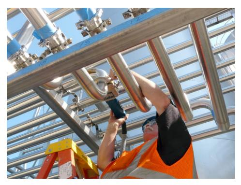
Im Laufe der Entwicklung sind Orbitalschweißköpfe immer kompakter geworden und ermöglichen daher sichere Schweißungen auch unter beengten Platzverhältnissen. Bilder: Orbitalum
