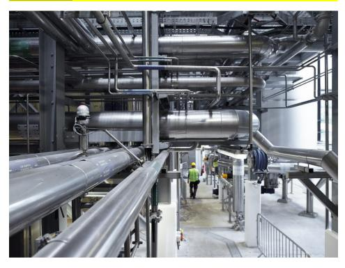
Große Förderdistanzen von bis zu 1000 Metern, Richtungswechsel und Höhenunterschiede sind bei der neuen Art des Trebertransports kein Problem mehr.
