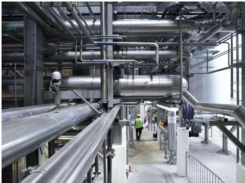
Große Förderdistanzen von bis zu 1000 Metern, Richtungswechsel und Höhenunterschiede sind bei der neuen Art des Trebertransports kein Problem mehr.
