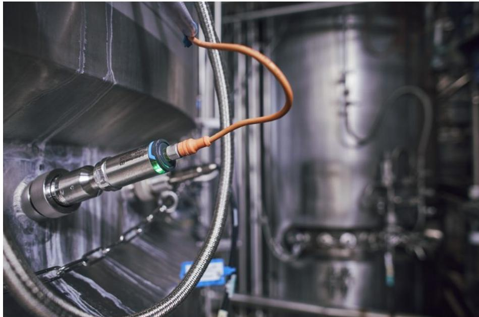
Das selbstkalibrierende Thermometer arbeitet mit einem integrierten Fixpunktsensor.
