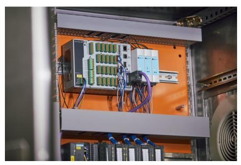
Die Hutschienenversion des Bildschirmschreibers ermöglicht die automatische Speicherung der Kalibrierzertifikate.
