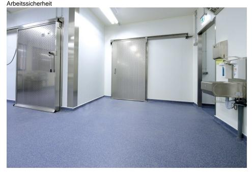
Geprüfte Qualität für die Lebensmittelbranche: Regelmäßig werden die Industriefußböden auf Reaktionsharzbasis kontrolliert (Bild: Silikal).
