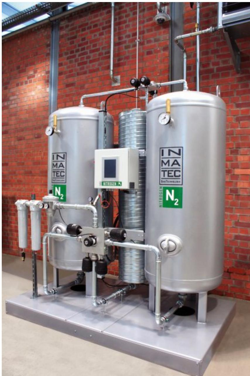
Der Stickstoffgenerator gewinnt bei der Trennung der N2- von den O2-Molekülen Stickstoff bei niedrigem Druckluftbedarf (Bild: Inmatec).
