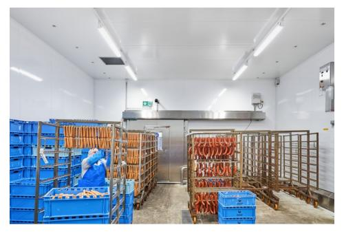
Beispiel für ein Beleuchtungskonzept in einem Fleisch verarbeitenden Betrieb. Für die korrekte visuelle Beurteilung des Erzeugnisses muss die Lichtquelle besonders gute Farbwiedergabeeigenschaften aufweisen (Bild: Norka).
