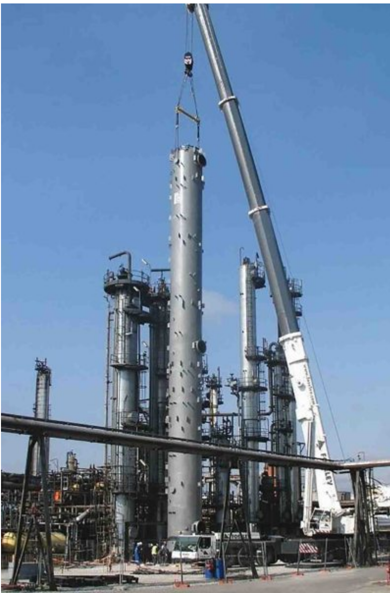
Beispiel für eine weitere industrielle ECR-Extraktionskolonne (Bild: Sulzer).
