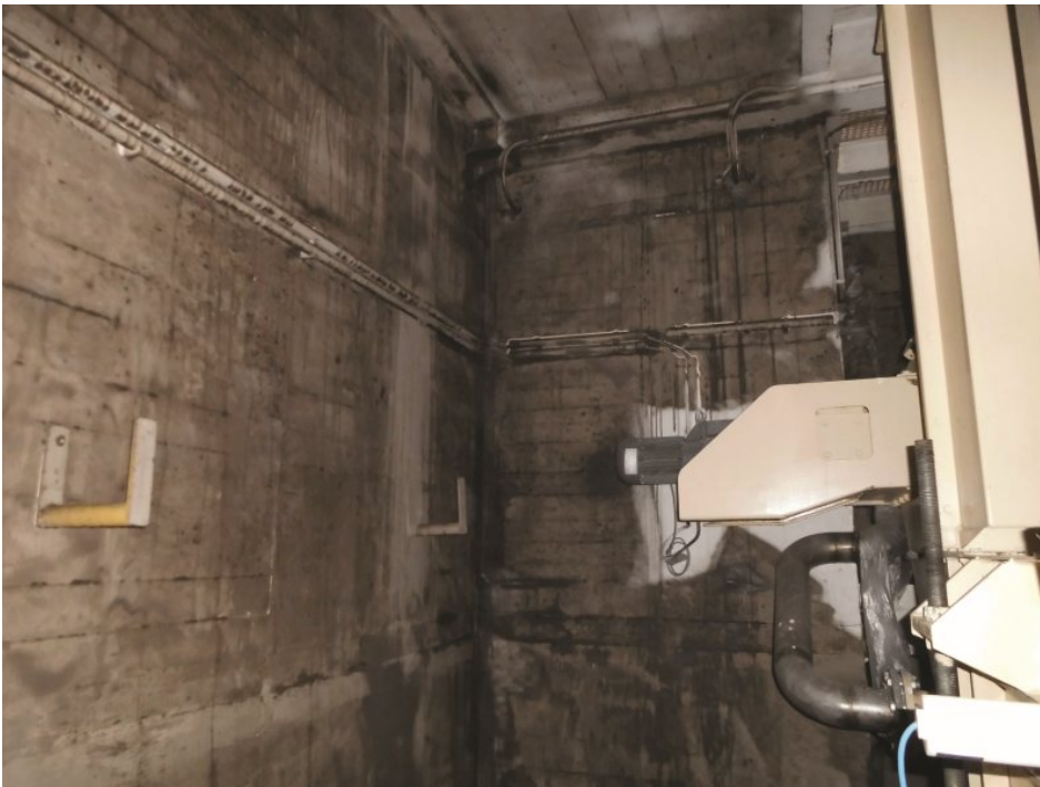
Vergleich einer Betonwand vor der Behandlung mit dem mehrlagigen Beschichtungssystem (Bild: Bioni).
