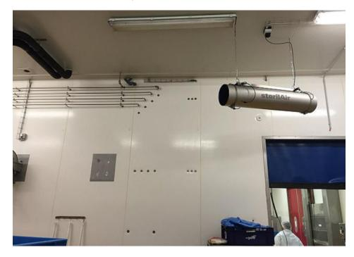
Durch den Einsatz des UVC-Umluftentkeimers wird nicht nur schnell, sondern auch kontinuierlich für eine sichere Produktionsumgebung gesorgt (Bild: sterilAir).
