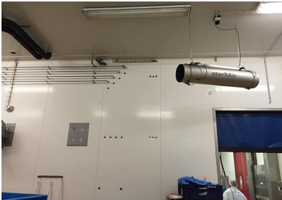
Durch den Einsatz des UVC-Umluftentkeimers wird nicht nur schnell, sondern auch kontinuierlich für eine sichere Produktionsumgebung gesorgt (Bild: sterilAir).
