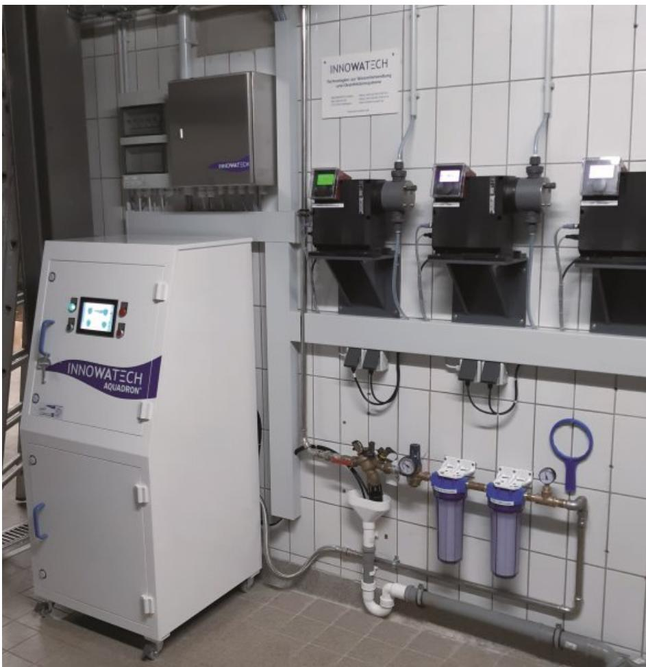
Dank Investition in die neue Anlage können pro Tag ca. 400 Liter Desinfektionsmittel selbst produziert werden zu – im Vergleich zu vorher – sehr geringen Kosten (Bild: Innowatech).
