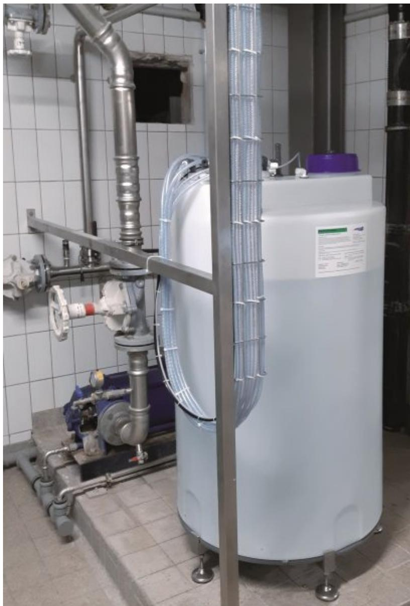
Dank Investition in die neue Anlage können pro Tag ca. 400 Liter Desinfektionsmittel selbst produziert werden zu – im Vergleich zu vorher – sehr geringen Kosten (Bild: Innowatech).
