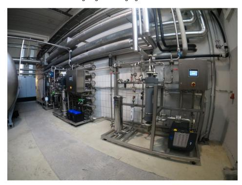
Das neue, komplett zusammenhängende Wasseraufbereitungssystem zur Brau- und Prozesswasseraufbereitung: links das Herzstück, die kompakt auf einem Rahmengestell montierte Umkehrosmoseanlage mit Verschneideeinrichtung und Dosieranlage, rechts die Membranentgasungsanlage (Bild: Grünbeck).
