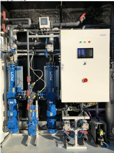
Technikraum einer anaeroben Abwasservorbehandlung (Bild: Flexbio).
