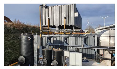
Anlagenverbund zur anaeroben Abwasserbehandlung mit Gasspeicherung und Gasaufbereitung (Bild: Flexbio).
