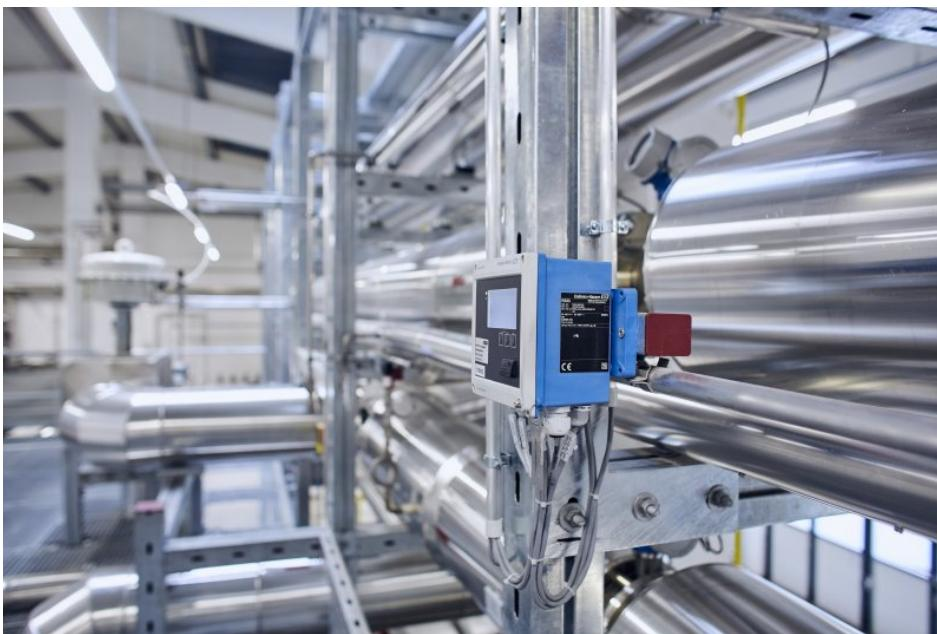
Der Dampfrechner erfasst Dampfmasse und Energiefluss (Bild: Endress+Hauser).
