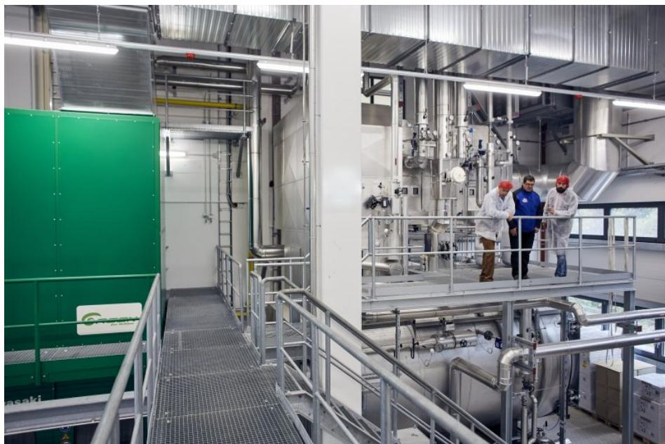
Eine Gasturbine erzeugt Elektrizität, Dampf und Warmwasser. Der Dampf wird über ein Leitungssystem in die ganze Molkerei transportiert (Bild: Endress+Hauser).
