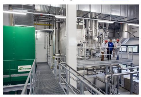
Eine Gasturbine erzeugt Elektrizität, Dampf und Warmwasser. Der Dampf wird über ein Leitungssystem in die ganze Molkerei transportiert (Bild: Endress+Hauser).
