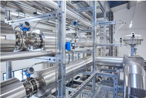
Zur Dampfmessung kommen andere Messinstrumente als in der Milchverarbeitung zum Einsatz, zum Beispiel Vortex-Durchflussmessgeräte und Dampfrechner (Bild: Endress+Hauser).
