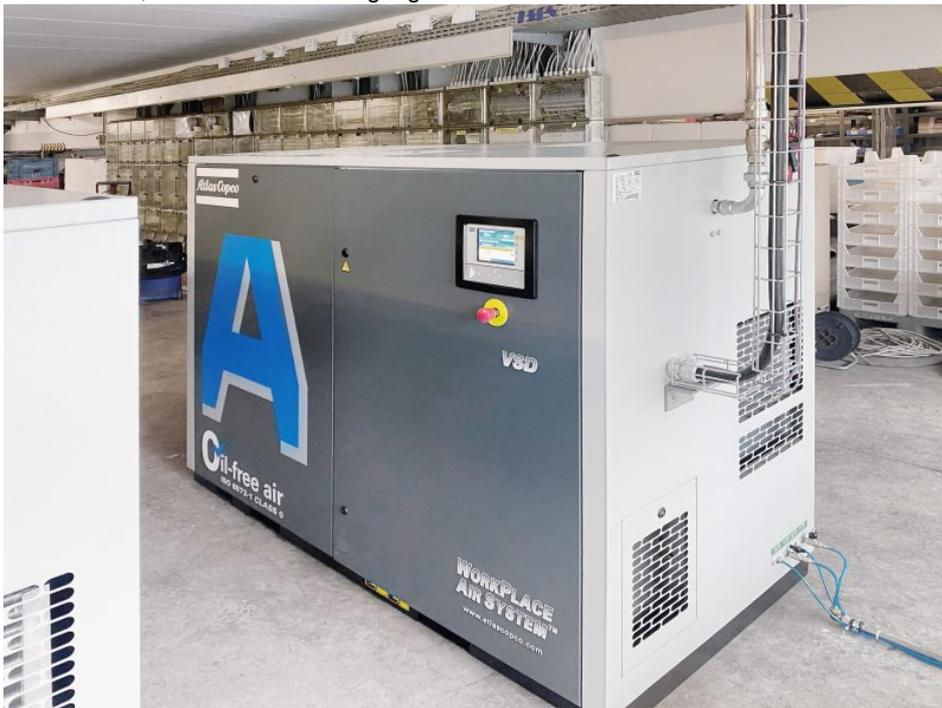
Zwei wassereingespritzte Kompressoren laufen im Wechsel und erzeugen 100 % ölfreie, saubere Luft (Bild: Oltrogge).
