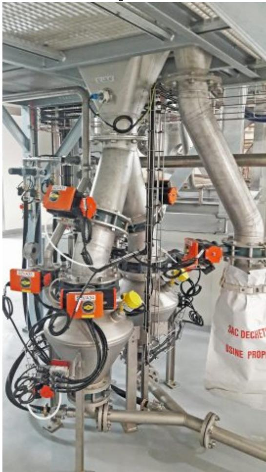
Die Verwendung von Doppelsendern reduziert den Höhenbedarf (Bild: Gericke).
