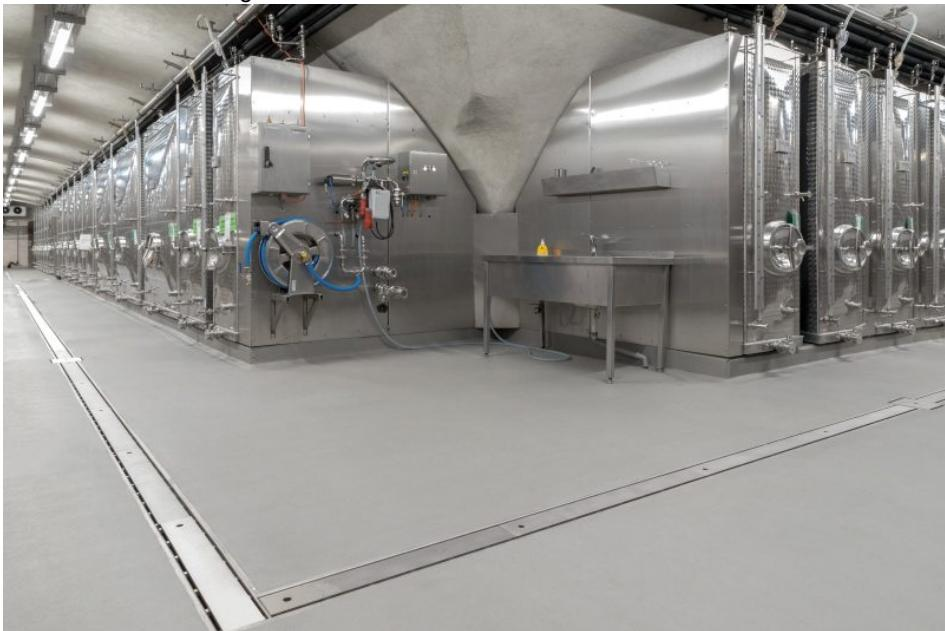
Die belastbaren Bodenbeschichtungen eignen sich dank Chemie- und Temperaturbeständigkeit für den Lebensmittelbereich (Bild: Sika).
