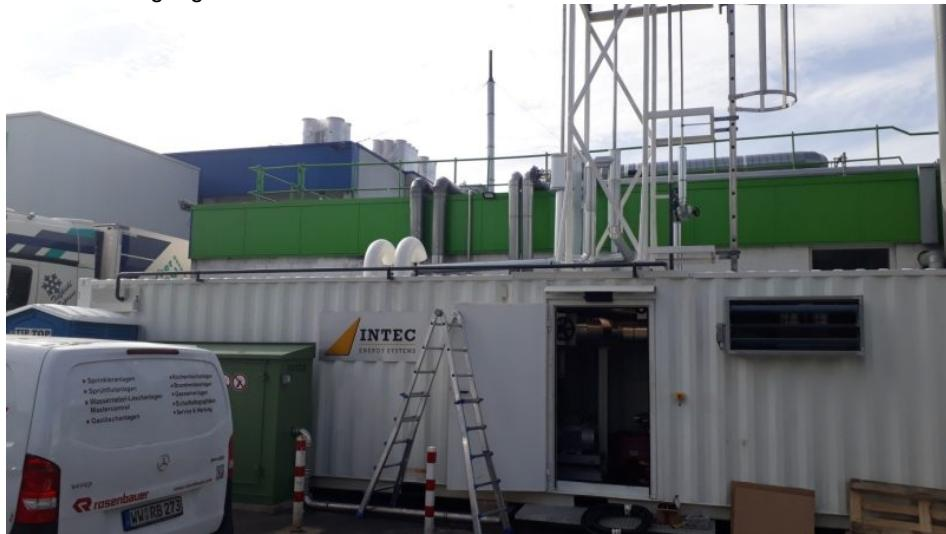
Das mobile Kesselhaus des schlüsselfertigen Erhitzersystems ist mit einer automatischen Feuerlöscheinrichtung versehen (Bild: Intec).
