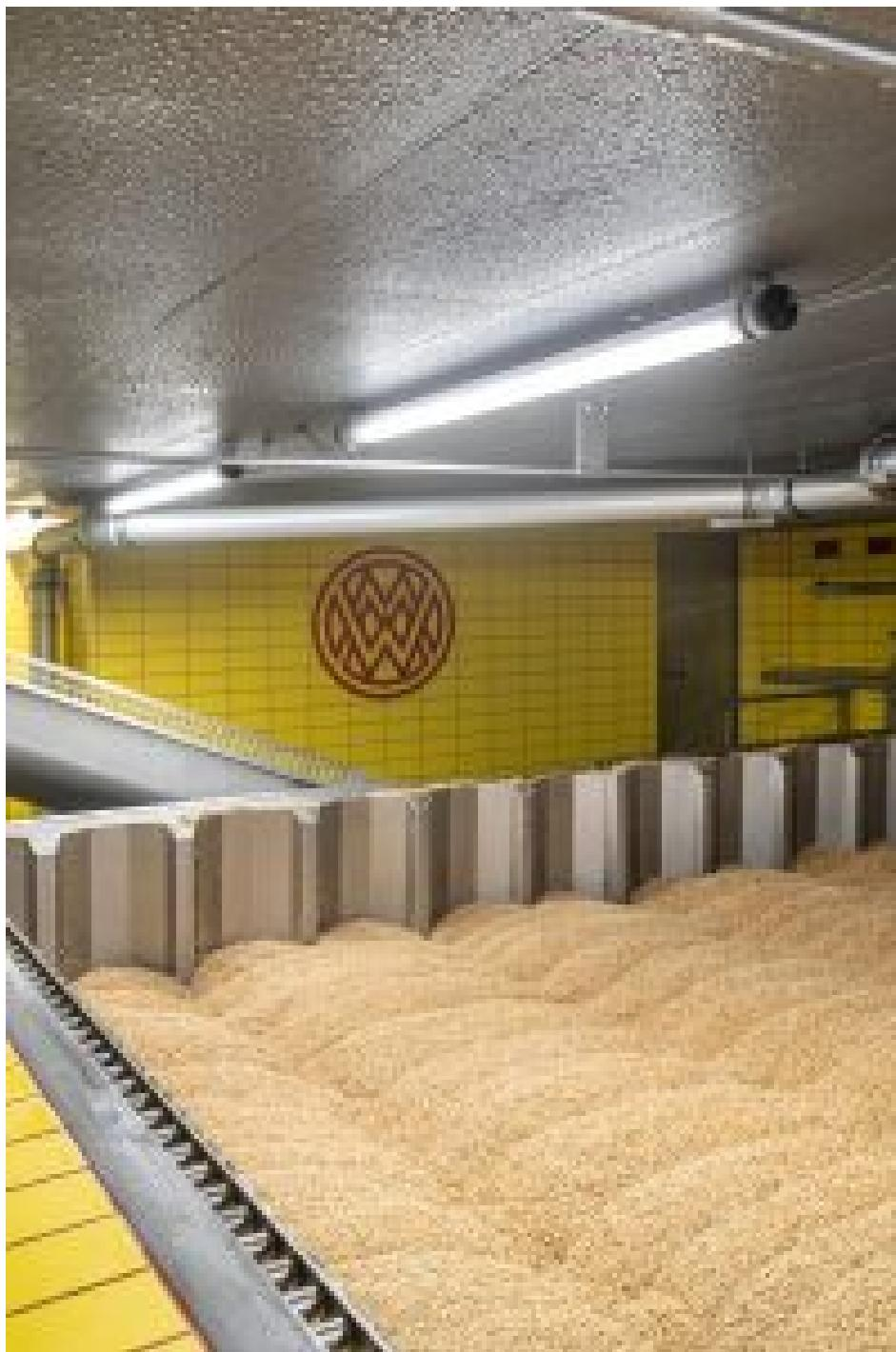
Mit jeweils 50 Watt Nennleistung erzeugt eine Leuchte einen Lichtstrom von 7450 Lumen (Bild: Norka/Tom Bauer).
