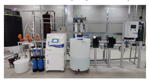
Mit dieser Anlage wird das Biozid direkt am Ort der Verwendung aus Kochsalz und Wasser hergestellt und dem Kühlwasser permanent im Rahmen der Trinkwasserverordnung hinzudosiert (Bild: Innowatech).
