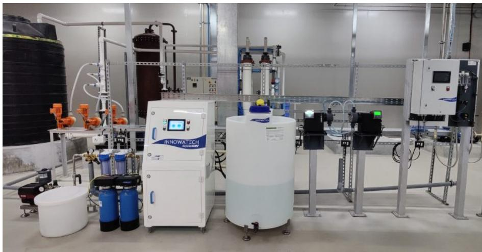
Mit dieser Anlage wird das Biocid direkt am Ort der Verwendung aus Kochsalz und Wasser hergestellt und dem Kühlwasser permanent im Rahmen der Trinkwasserverordnung hinzudosiert (Bild: Innowatech).
