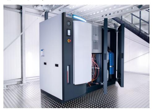
Die neuen modularen Dampferzeuger benötigen weniger Platz. Links unten ist die von weitem sichtbare Wasserstandsanzeige zu sehen, die große LED im oberen Bereich informiert über den Gerätestatus (Bild: Certuss).
